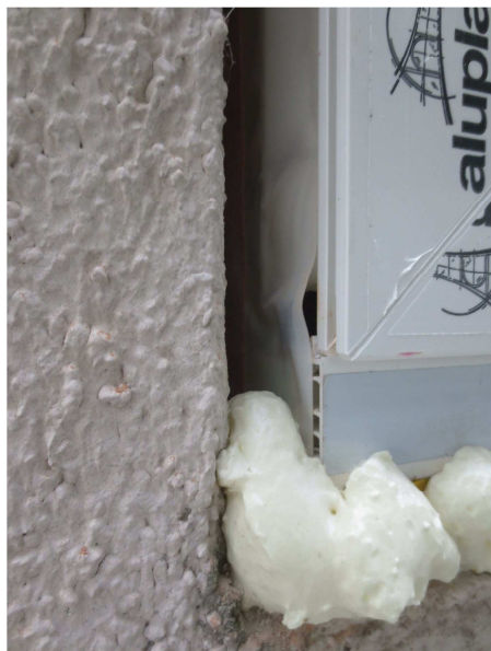
Fugenüberprüfung Bilder DEN GmbH & Co. KG
